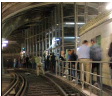
Visite par petits groupes d'une section de tunnel mise en sécurité.
