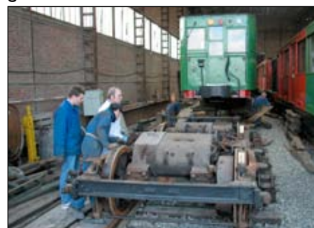
Après la remise aux couleurs d'origine de la motrice active, des travaux de révision électrique et mécanique (changement d'un moteur, du câblage, révision du freinage et des organes de roulement ...) ont eu lieu. Ici, la révision du bogie avant.
