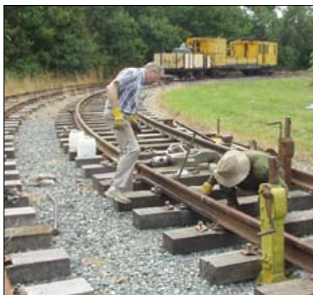
Pose de la voie sur le site Mayennais.
